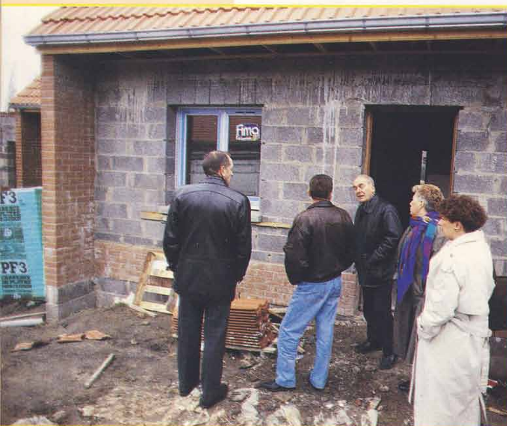
Le suivi et la coordination des travaux sur les chantiers mobilisent beaucoup du temps des élus municipaux
