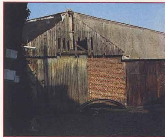
La disparition de la Ferme Leroux permettra de désenclaver des terrains.
