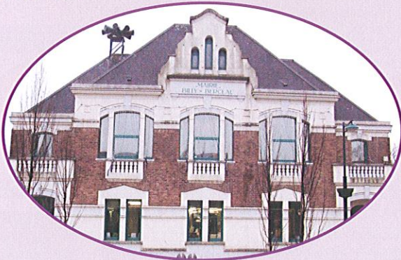
La Mairie a été reconstruite au même emplacement mais dans un style architectural différent
