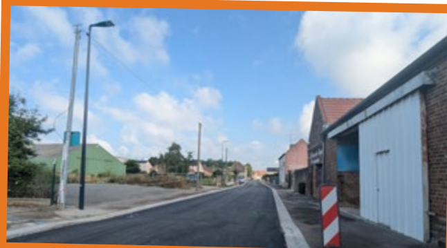
RUE PASTEUR : installation de mâts d'éclairage public (100% LED), passage des câbles aériens en souterrain, pose de l'enrobé
