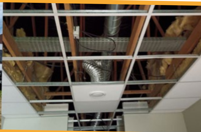
USBB : rénovation du cheminement face à l'actuelle buvette, installation d'une VMC adaptée dans les vestiaires, nouvel éclairage 100% LED au stade synthétique
