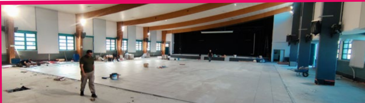
ESPACE FRANÇOIS MITTERRAND : pose du carrelage, montage de la tribune et installation du bar
